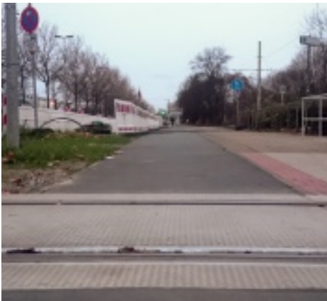
Ein glatter Übergang von Radweg zu Bahnschienen bei der Gifhoner Straße. Vorher gab es Zentimeter hohe Unterschiede zwischen Radweg und Schienen.
