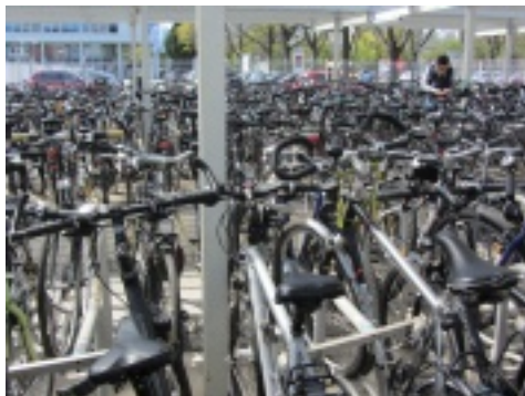
Fahrradstand der Siemens AG in der Ackerstraße: Verhakelte Lenker aufgrund des zu geringen Seitenabstands.
