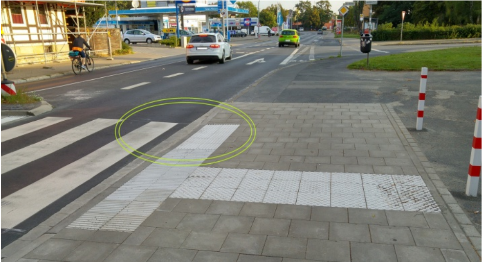
Neue Querung am Büldenweg vor dem B58 (die Radwegführung auf der Fahrbahn und die deplatzierte Laterne außerhalb des Bildes sind nochmal andere Geschichten...)
