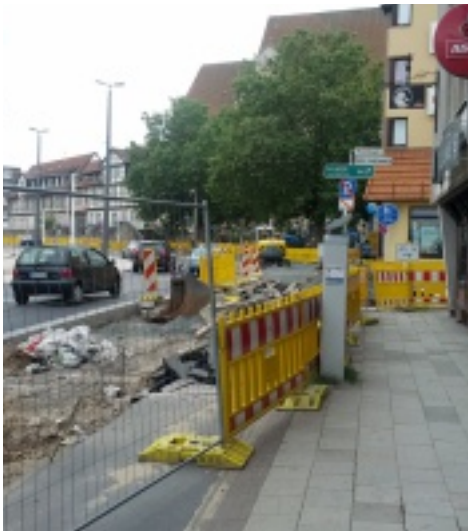
Die Baustelle an der Stobenstraße: Der Kfz-Verkehr wird wieder auf zwei Fahrbahnen, während sich der Fußgänger- und Radverkehr durch ein enges Labyrinth winden müssen.
