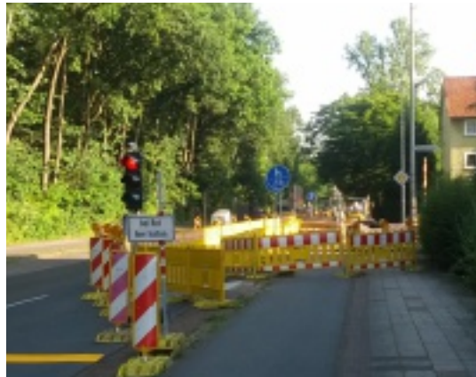
An dieser Baustelle am Bienroder Weg/Michelfelderplatz ist der Geh- und Radweg vorbildlich gesichert und mit einer ausreichenden Breite versehen. Die Überleitung vom Radweg in den Notweg ist gut gelungen.
