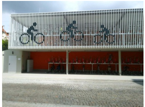
Gut dimensioniert, optisch ansprechend: Oranienburg hat im Jahr 2018 ein neues Fahrradparkhaus am Bahnhof eröffnet. Die Finanzierung in Höhe von 1,75 Millionen Euro erfolgt durch das Programm "Aktive Stadtzentren".
